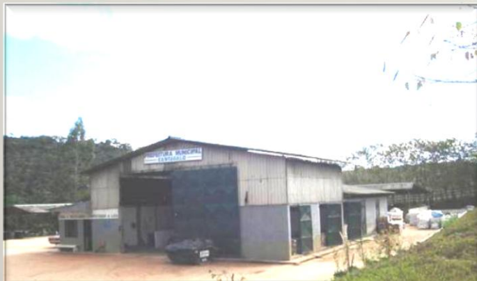
Usina de Reciclagem e Compostagem
