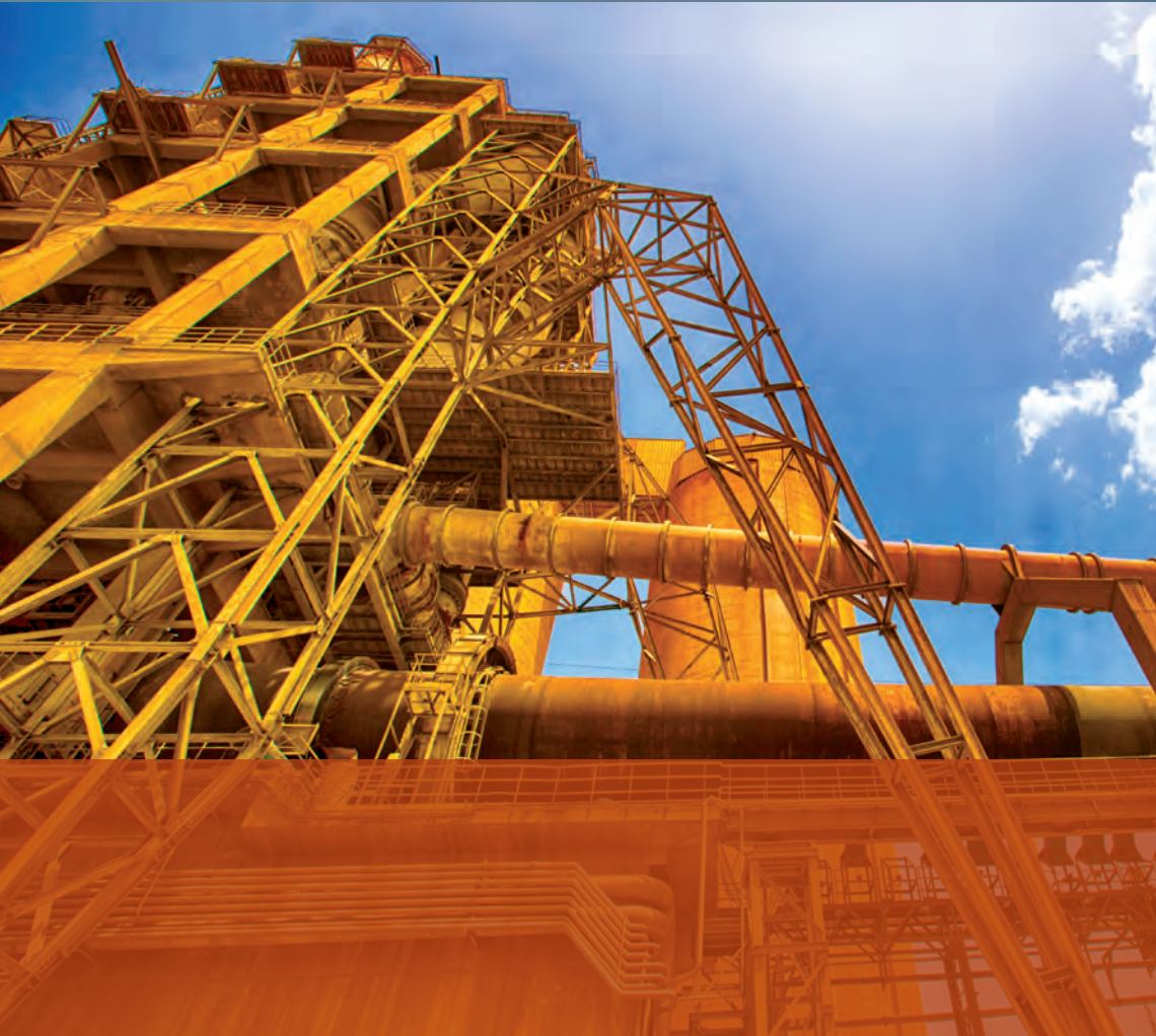
Vista da torre de pré-aquecedores e pré-calcinador
