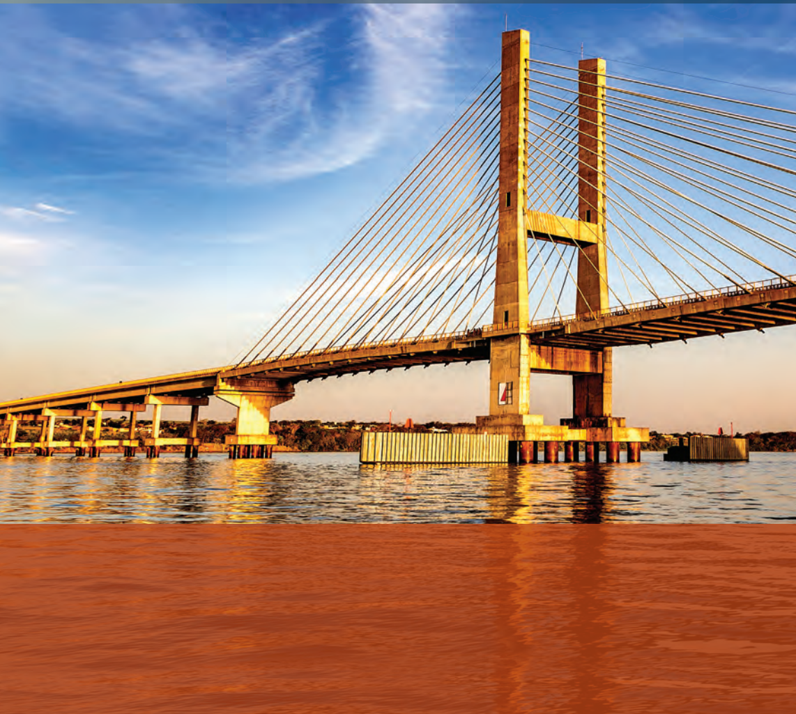
Ponte estaiada sobre o Rio Paraná, entre São Paulo e Mato Grosso do Sul
