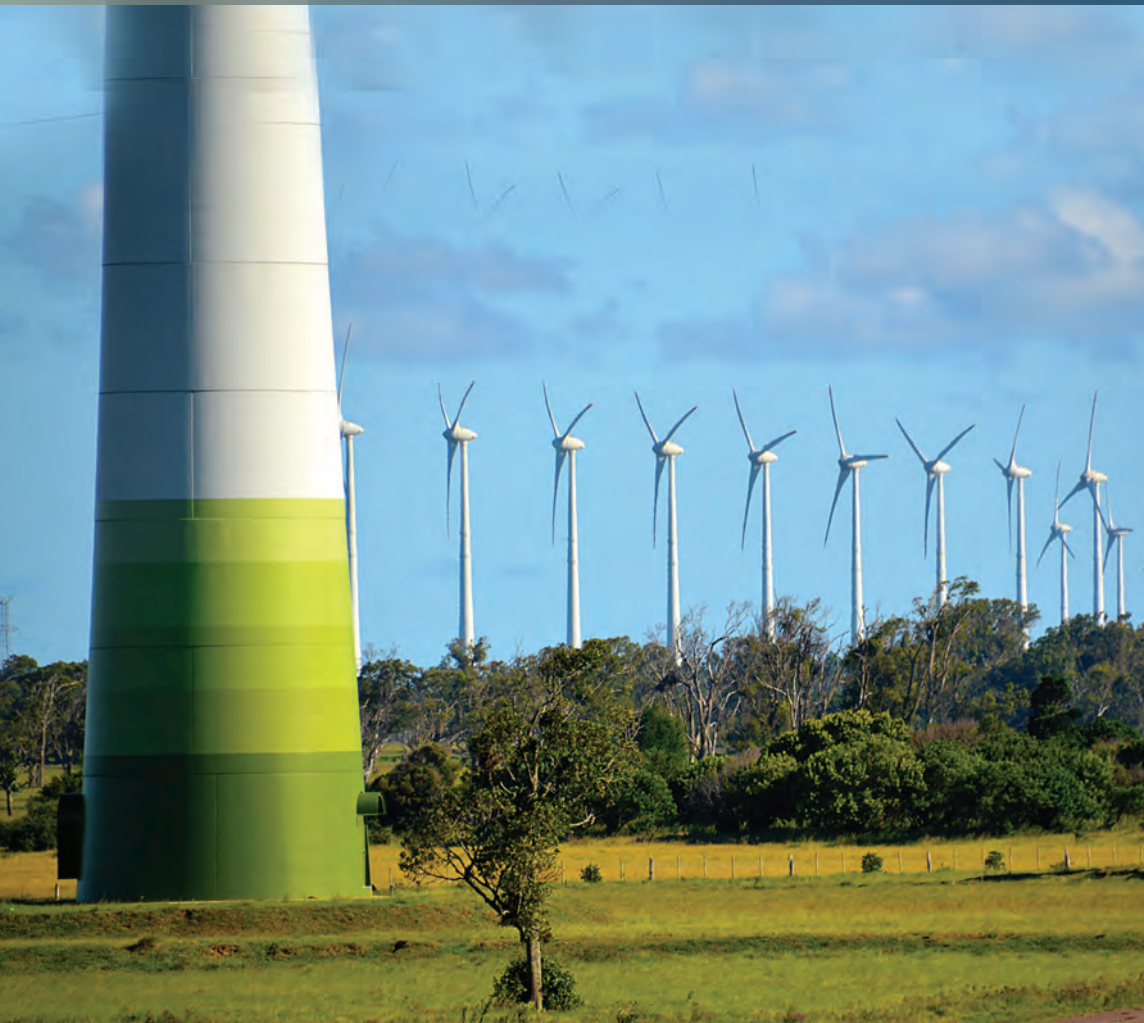
Torres em concreto do Parque Eólico de Osório/RS
