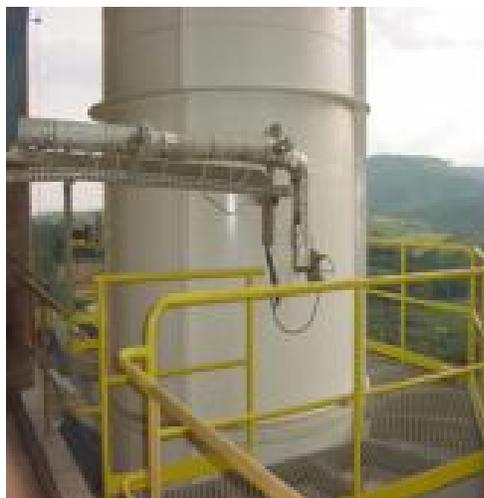
Foto: Chaminé e Sonda do Analisador Contínuo.
