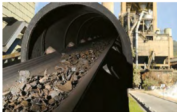
Figura 18 - Correia transportadora de resíduos
