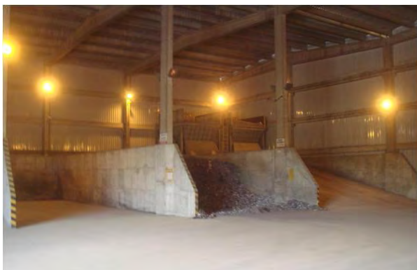
Figura 19 - Galpão de resíduos para coprocessamento Fonte: CIMPOR (2010)
